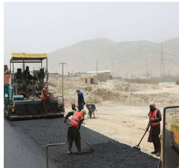
Travaux routiers à Kaboul
